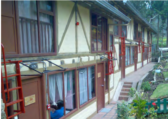
Fluchtleitern der Caritas Vorarlberg: ein erhebliches Risiko
